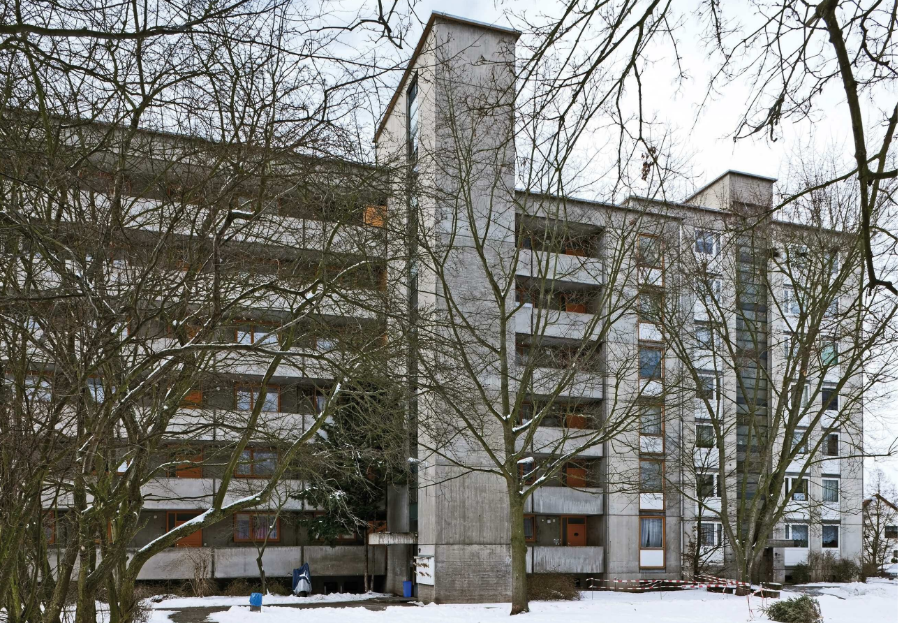
Vor den Modernisierungsmaßnahmen: triste Fassaden und ungepflegte Grünanlagen im FinkenPark Fürth.
