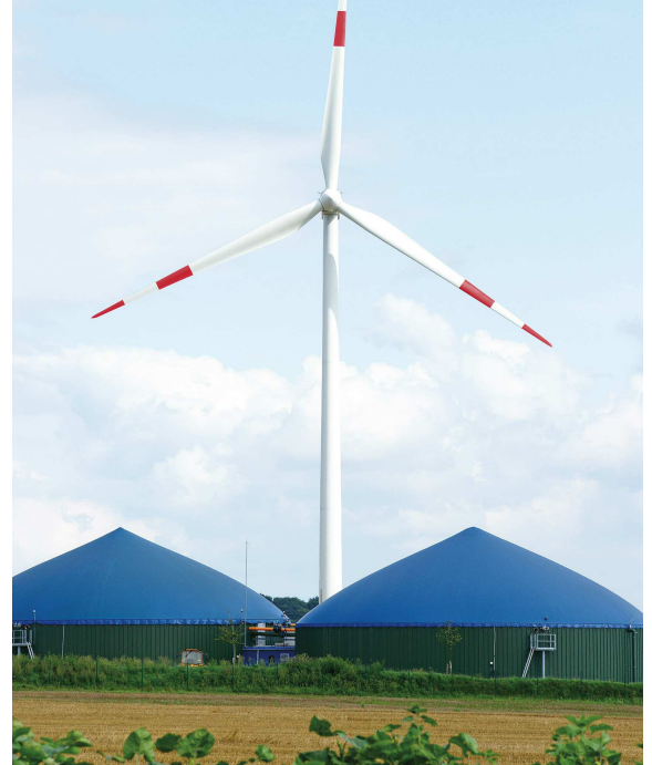
Biogas- und Windkraftanlage
