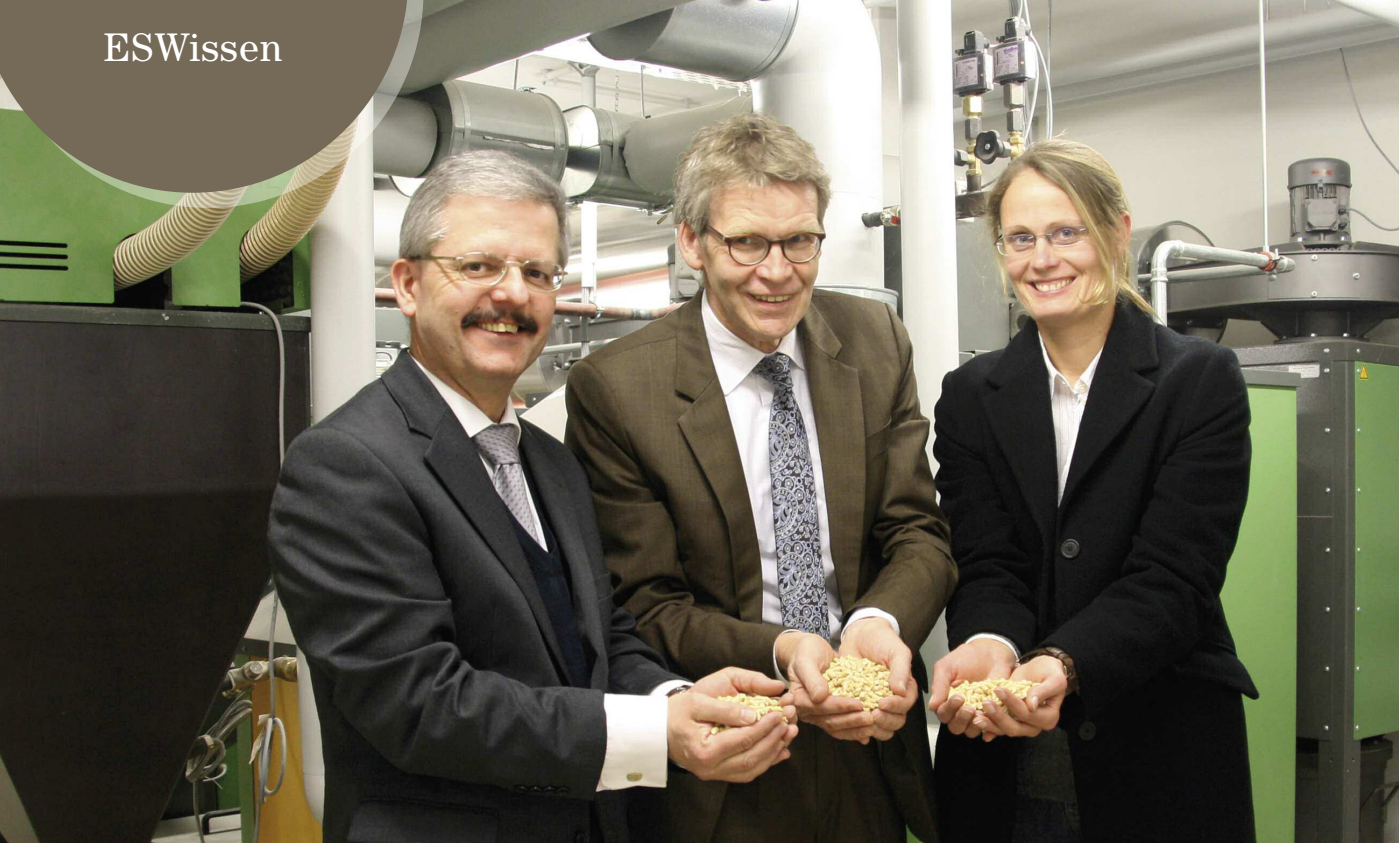
Robert Flock, Geschäftsführer der ESW Unternehmensgruppe (Mitte), Horst Hacker und Ulrike Bauer, N-Ergie Effizienz GmbH, vor der Holzpelletanlage, die alle Häuser des Projekts „Familiennest“ und die Kita „Kinderinsel“ in der Nürnberger Wandererstraße versorgt.
