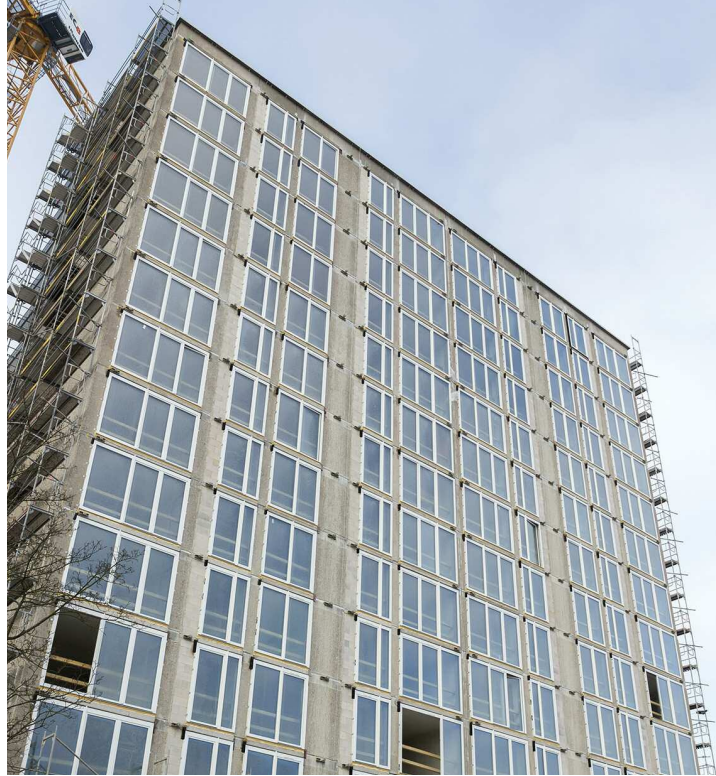
Sichtbare Fortschritte bei der Sanierung des Hochhauses
