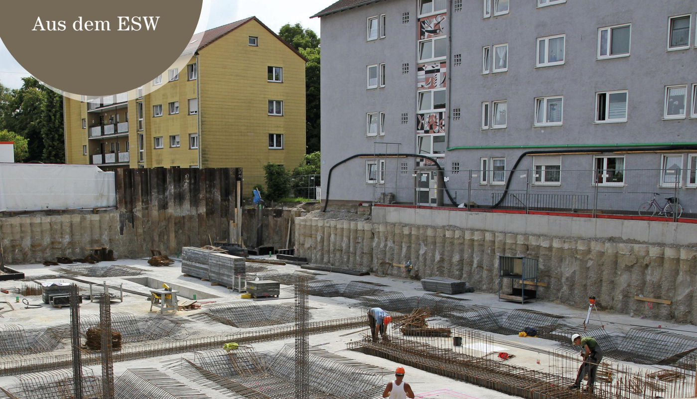
Die Bauarbeiten für die neuen Familienwohnungen haben bereits begonnen
